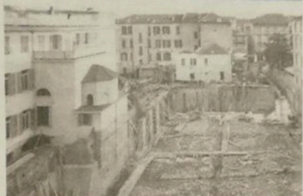
I lavori di costruzione del Centro Ariston, cominciati nel 1953
