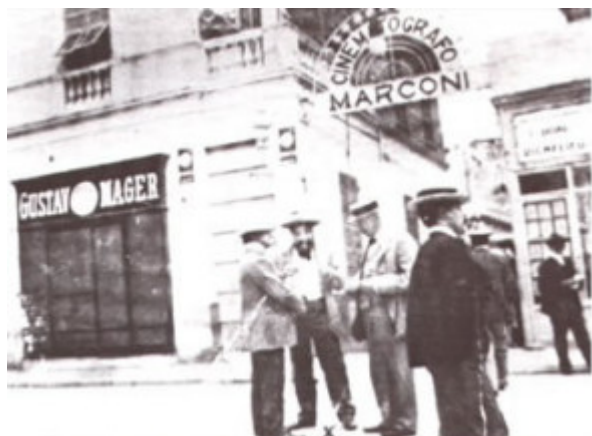
1923 – Il Centrale nasce dalle spoglie del vecchio Marconi
